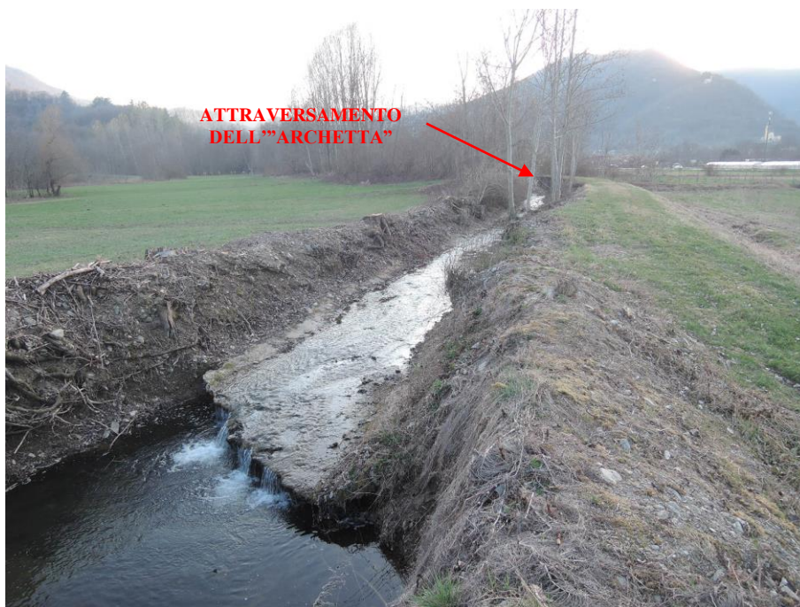
Stato attuale: rivestimento fondo alveo a valle dell'attraversamento dell'"Archetta".
