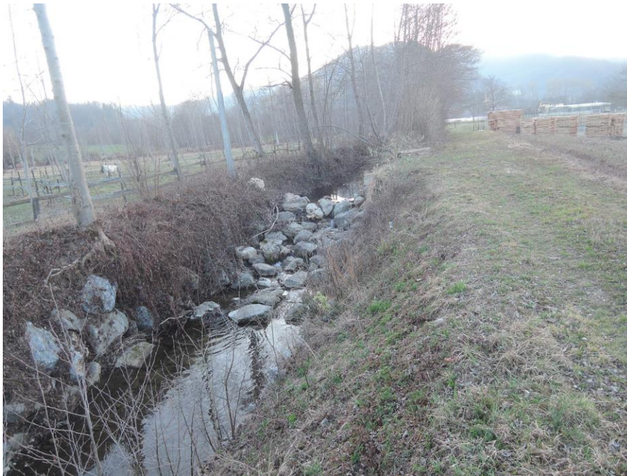
Stato attuale: scivolo in massi in corrispondenza opera di presa irrigua esistente.
